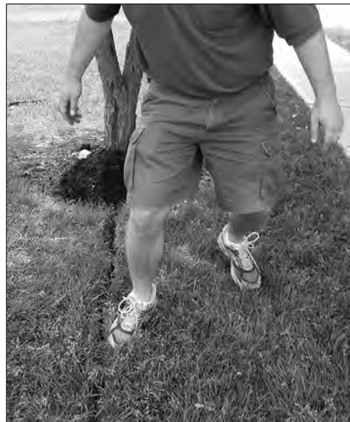
Empuje la hierba a cerrar la zanja.
