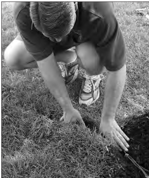
Empuje el alambre en la zanja.
