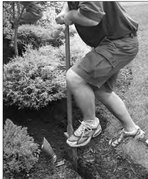
El CAST Instrumento que Cava (CWTT) corta un ideal de zanja estrecho para el alambre.
