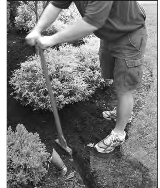
Empuje y tire el instrumento para hacer una apertura para el alambre.
